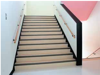
△小学生に合わせて、段差を低くし、段数を増やした階段
