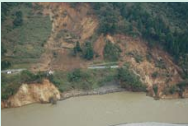
中越大震災で土砂に埋まった県道川口岩沢線
