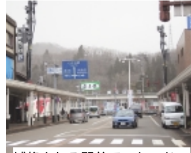
補修される駅前アーケード
