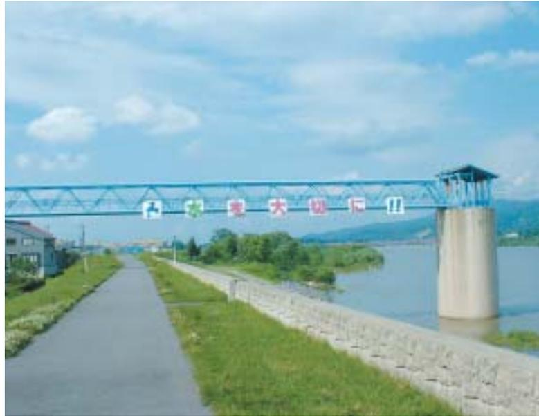
信濃川・取水塔と水間橋～信濃川の水を1日平均13,000トンくみ上げています
