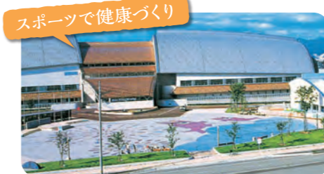
スポーツで健康づくり 総合体育館 General Gymnasium
