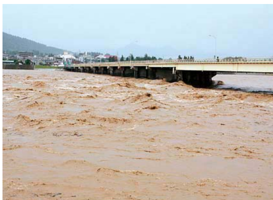
△はん濫危険水位を超えた信濃川（旭橋下流）
