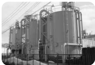
工業用水道浄水場
