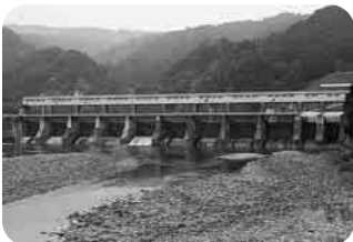
(JR宮中発電所)
