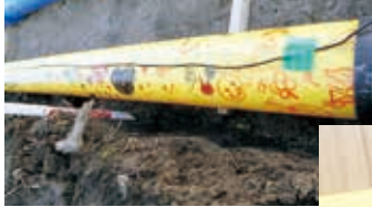
△埋設されたガス管
