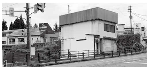
△解体後（9月15日撮影）
