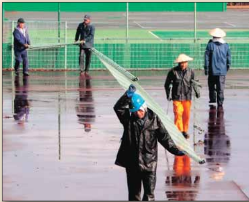
▷白山運動公園テニスコートのフェンス撤去作業の様子。小千谷の冬支度の一部は、シルバー人材センターのみなさんのこのような社会参加によって支えられています。
