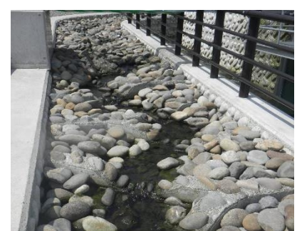
せせらぎ魚道の様子
