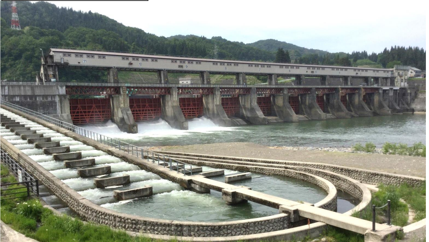
かりゅうがん みやなかしゅすい ぎょどう のぞ 下流右岸から宮中取水ダム魚道を望む
