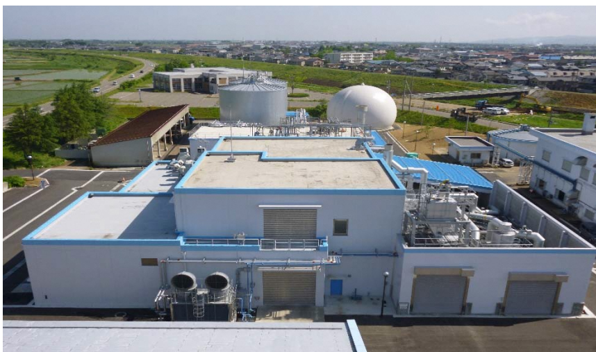
生ごみバイオガス発電センター
