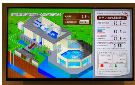
館内に設置された地中熱の利用状況モニター
