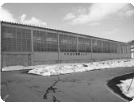
堆肥センター
