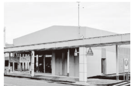
ホントカ。(演アンカー)に24時間の公衆トイレ
