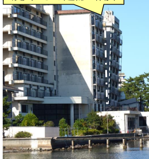
震災による建物の傾斜
