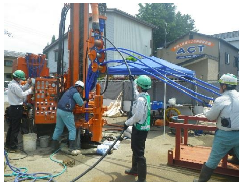
図書館等複合施設建設予定地での地中熱応答試験 (令和3年6月21日)
