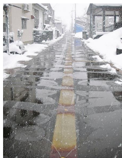
整備された消雪パイプ
