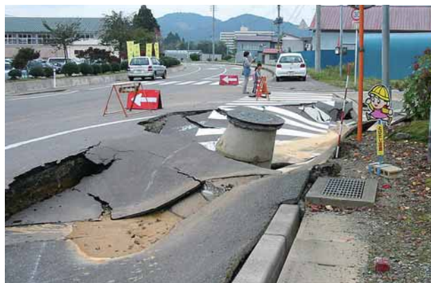
浮き上がるマンホール(千谷)
