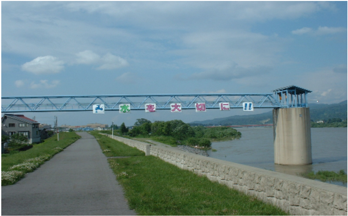
小千谷浄水場水管橋
