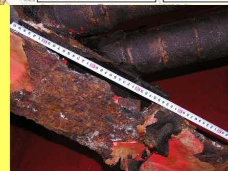
鋼桁の腐食 51
